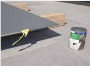
Nanesení barvy ColourPlus™ na hranu před montáží
