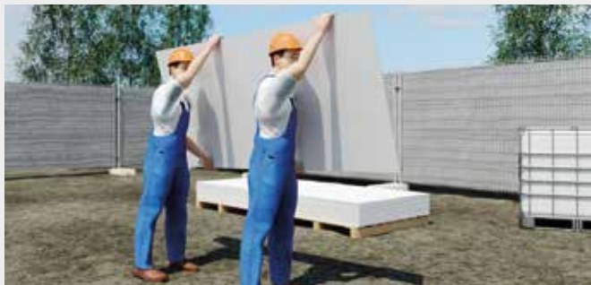
Fasádní desky HardiePanel® noste vždy na výšku
