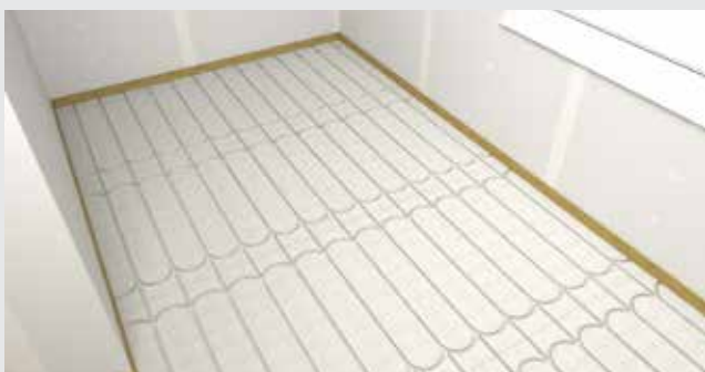
Pokládka prvků fermacell® Therm25™.
