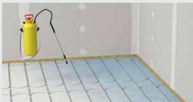
Aplikace hloubkové penetrace fermacell® na fermacell® Therm25™.
