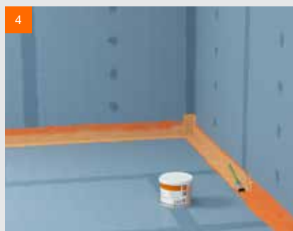
4 Těsnicí pásku přetřete tekutou fólií fermacell™ ihned po přitlačení.
