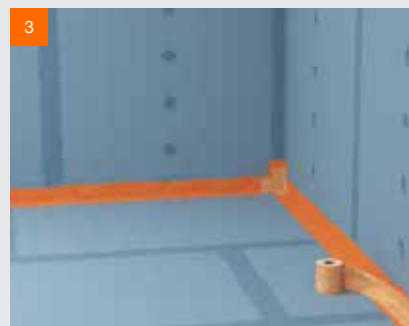
3 Zatlačte těsnicí pásku fermacell™ do vlhké tekuté fólie.
