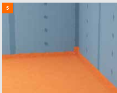
5 Celoplošné utěsnění povrchu v oblasti W1-I.
