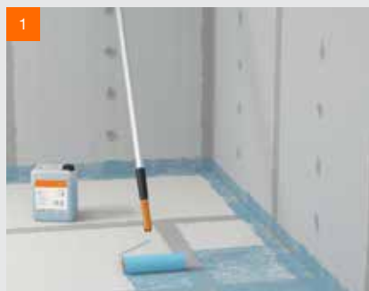
1 Na přilehlou plochu stěn a podlahy naneste válečkem hloubkovou penetraci fermacell™.
