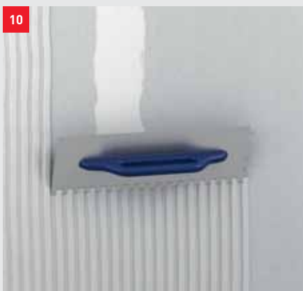
Nanesení lehké malty fermacell HD v šíři pásu armovací tkaniny
