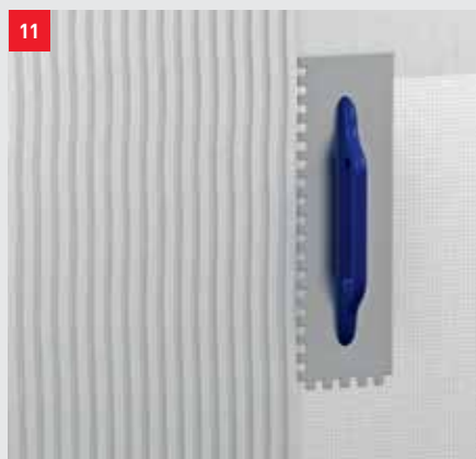
Vtlačení armovací tkaniny fermacell HD do maltového lože
