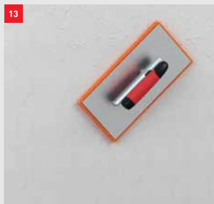
Úprava povrchu lehké malty fermacell HD pomocí pěnového hladítka
