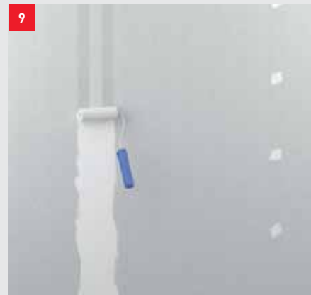
Nanesení armovacího lepidla fermacell HD
