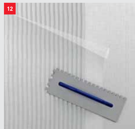
Překrytí pásů armovací tkaniny
