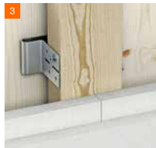
3 Opláštění na stavěcích trměnech a dřevěných latích
