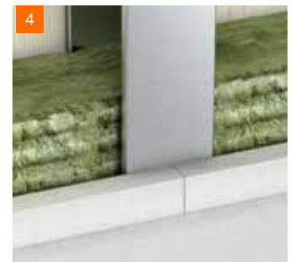
4 Opláštění na předsazené stěně
