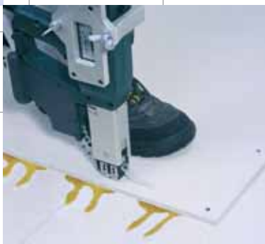
Obrázek 6: spojení obou vrstev šrouby FERMACELL
