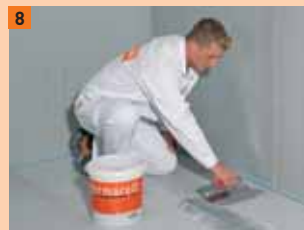
8 Podle potřeby spárování stykové spáry a spojovacích prvků
