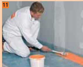
11 Tekutou fólii FERMACELL nanášejte v rozích pomocí štětce
