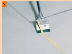
7 Vypěněné lepidlo po vytvrdnutí odstraňte
