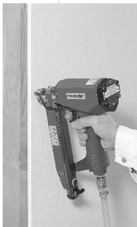
Sponkování desek FERMACELL na dřevěnou spodní konstrukci
