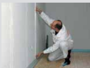
Zkontroluje se výška podsypu
