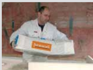
Smísení v míchačce na beton
