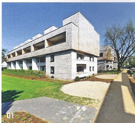
01, 02, 03 > Se dřevem jako stavebním materiálem a vnitřním vybavením ze sádrovláknitých desek odpovídá nástavba bytových domů v ulici Bebelallee v Alsterdorfu moderním požadavkům na ekologické a trvale udržitelné stavby
