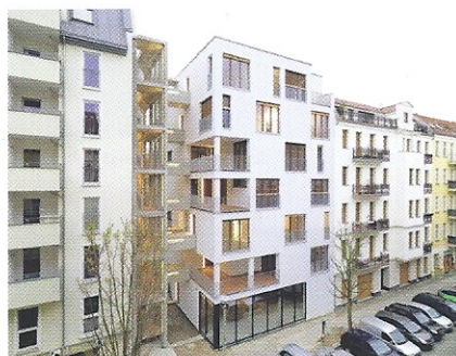
Stavba vícepodlažní budovy na bázi dřeva s opláštěním ze sádrovláknitých desek (bytový dům v Berlíně)
